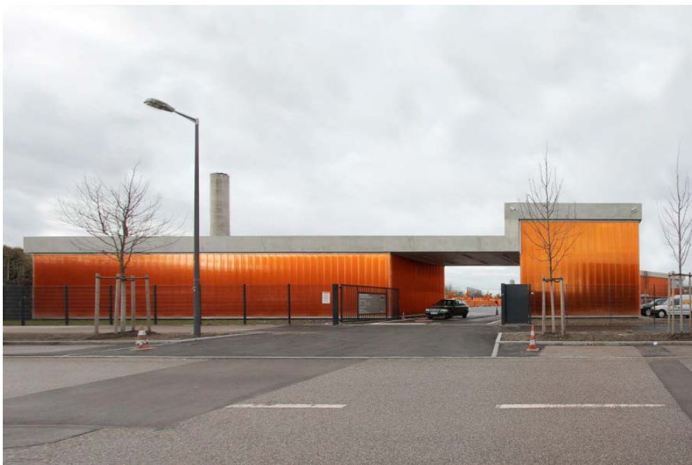
Schickes Ambiente, noch ohne Espresso-Tankstelle: Wertstoffhof in der Lindberghstraße, München, gebaut von Hess, Talhof, Kusmierz (Bild: Architekten anlässlich der „Architektouren“)
