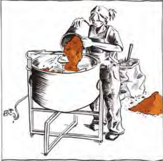
DURCH DIE ZUGABE VON 15 BIS 35% WASSER ERHÄLT MAN EINE DICKFLÜSSIGE MASSE. UM RISSE ZU VERMEIDEN, IST ES MANCHMAL NOTWENDIG, SAND UND/ ODER PFLANZENFASERN HINZUZUFÜGEN.
