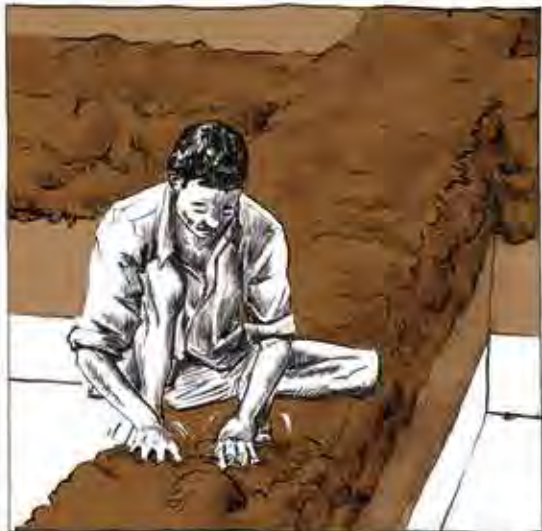
DIE LEHMKLUMPEN WERDEN ZU SCHICHTEN VON ETWA 50 BIS 60 CM HÖHE AUF EINEM SOCKEL GESTAPELT, UM EINE BESSERE VERBINDUNG UNTEREINANDER ZU ERHALTEN. WERDEN SIE OFT MIT ETWAS SCHWUNG GEWORFEN.
