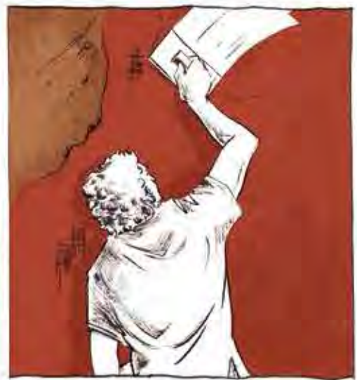
MIT DEM GRUNDPUTZ KÖNNEN AUCH UNEBENHEITEN AUSGEGLICHEN WERDEN, DAMIT EINE EINHEITLICHE OBERFLÄCHE ENTSTEHT. DIE SEHR SANDIGE UND/ ODER FASERIGE MISCHUNG VON 2 BIS 3 CM DICKE WIRD MIT EINER KELLE ODER EINEM SPACHTEL AUFGETRAGEN.
