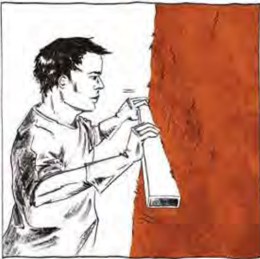
DIE PLANHEIT WIRD MIT EINER GROßEN RICHTLATTE GEPRÜFT.
