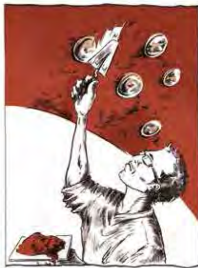
MIT DEM GRUNDPUTZ KÖNNEN AUCH UNEBENHEITEN AUSGEGLICHEN WERDEN, DAMIT EINE EINHEITLICHE OBERFLÄCHE ENTSTEHT. DIE SEHR SANDIGE UND/ ODER FASERIGE MISCHUNG VON 2 BIS 3 CM DICKE WIRD MIT EINER KELLE ODER EINEM SPACHTEL AUFGETRAGEN.
