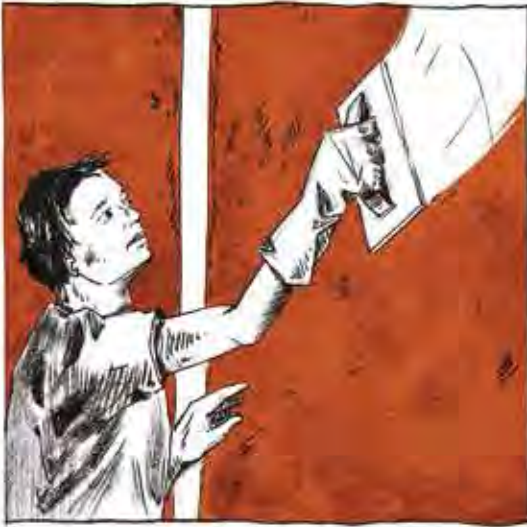
WENN DIE WAND TROCKEN IST, WIRD EIN (EVENTUELL MIT LUFTKALK STABILISIERTER) LEHMPUTZ AUFGETRAGEN.
