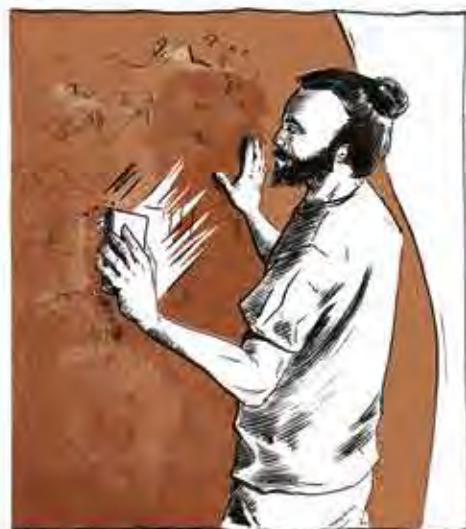
VOR DEM VERPUTZEN MUSS DER UNTERGRUND VORBEREITET WERDEN: FÜR EINE BESSERE HAFTUNG WIRD DIE WAND AUFGERAUT UND ANSCHLIEßEND BEFEUCHTET.
