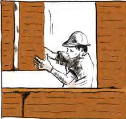
DIE VORGEFERTIGTEN MODULE WERDEN MIT LEHMMÖKTEL ZUSAMMENGEFÜGT.
