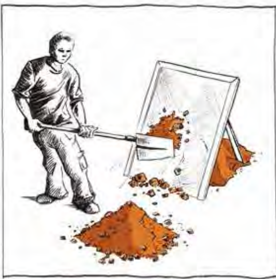
DIE ERDE WIRD GESIEBT, UM NUR LEHM, SCHLUFF UND SAND ZU ERHALTEN.
