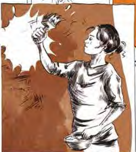
VOR DEM VERPUTZEN MUSS DER UNTERGRUND VORBEREITET WERDEN: FÜR EINE BESSERE HAFTUNG WIRD DIE WAND AUFGERAUT UND ANSCHLIEßEND BEFEUCHTET.
