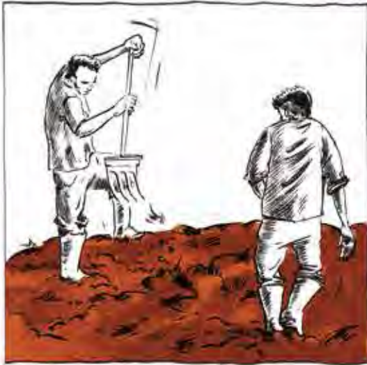
DER LEHM WIRD MIT 15 BIS 30 % WASSER VERMENGTE, UM EINE HOMOGENE, FORMBARE MISCHUNG ZU ERHALTEN, HIER MIT STROHZUSATZ.
