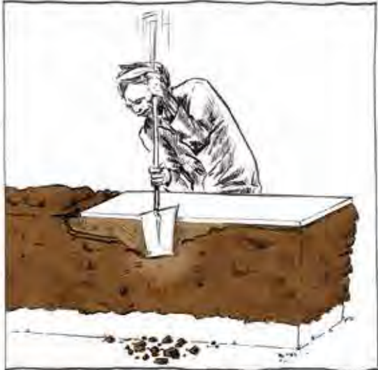
DIE BEIDEN SEITEN DER WAND WERDEN MIT EINEM SPATEN ODER EINEM ANDEREN SCHNITTWERKZEUG BEGRADIGT.
