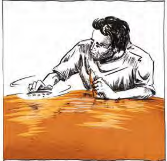
DIE SCHICHT DES FEINPUTZES IST SEHR DÜNN. HIER WURDE EINE BESONDERE MISCHUNG AUS LEHM, SAND UND WACHS MIT DER KELLE AUFGETRAGEN UND POLIERT. DAS WACHS ERHÖHT DIE WIDERSTANDSFÄHIGKEIT.
