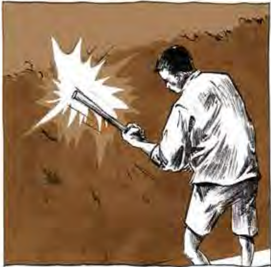
JEDE SCHICHT WIRD BEKLOFFT, UM WÄHREND DER ETWA ZWEI WOCHEN DAUERNDEN TROCKENPHASE EVENTUELL SICH BILDENDE RISSE ZU VERSCHLIEßEN.
