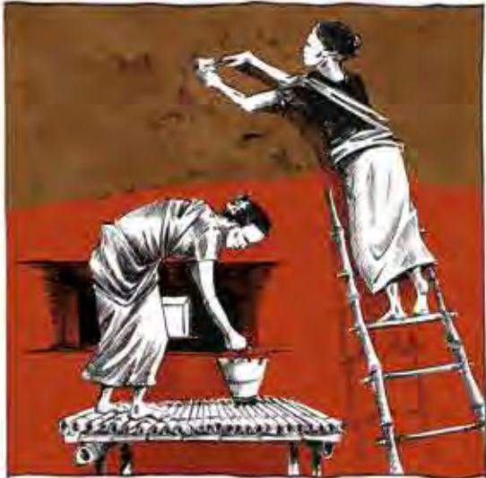
DIE ÜBERSTEHENDEN STROHRESTE WERDEN ENTFERNT, UM EINE GLATTE WAND ZU ERHALTEN. SOLL DIE OBERFLÄCHE VERPUTZT WERDEN, EMPFIEHLT ES SICH DIE WAND LEICHT AUFZURAUEN, UM DEM PUTZ EINEN GUTEN HALT ZU GEBEN.
