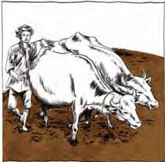
DER LEHM STAMMT MEISTENS VOM BAUGRUND UND WIRD IN PLASTISCHEM ZUSTAND VERKNETET (15 BIS 30% WASSER). HIER WURDE REISSTROH HINZUGEFÜGT UND VON BÜFFELN DURCHGEWALKT.
